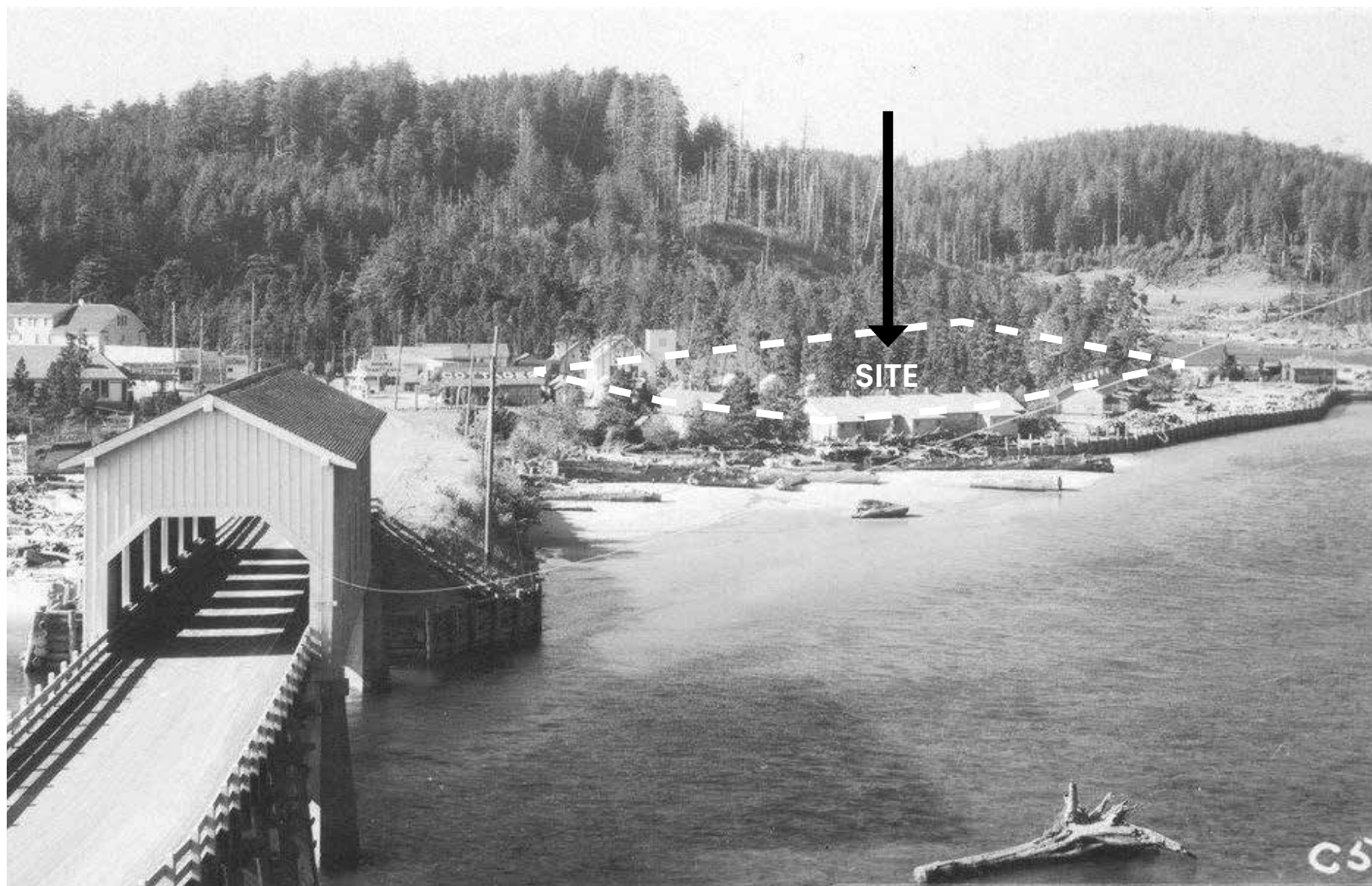
Construcción de la autopista 101 El Centro de Taft se mueve de la calle 51 a la autopista 101
